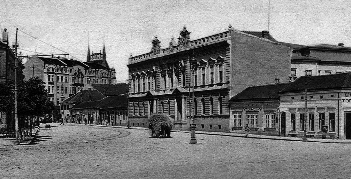
Zgrada nekadašnjeg Okružnog suda
